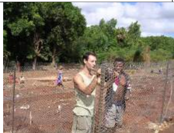
Pose du grillage.
